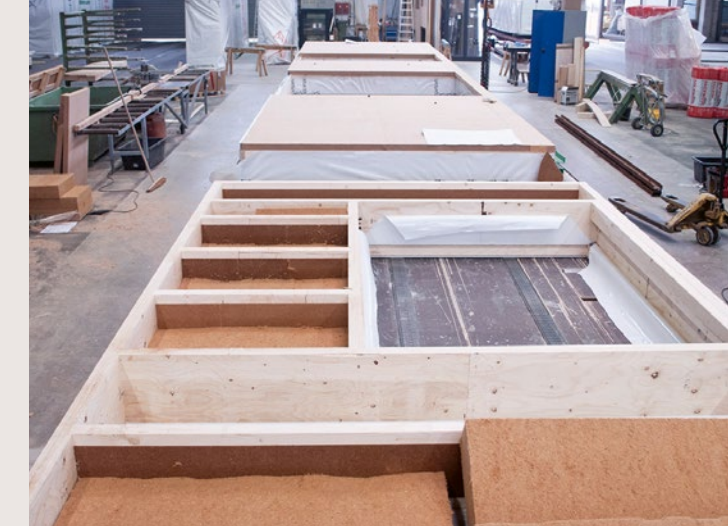
Fertigung eines großen Außenwand-Elements mit dem Holzbausystem von STEICO
